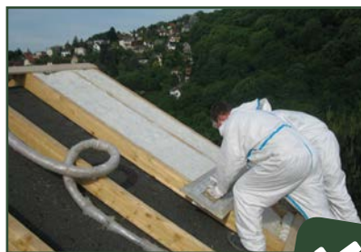
Rekonštrukcia strechy zhora bez narušenia komfortu bývania
