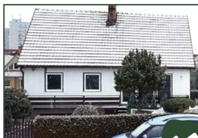
Strecha zateplená kanadskou izoláciou
